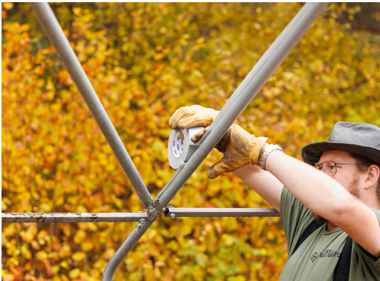
Tejpa den yta där plasten ligger mot bågen.
